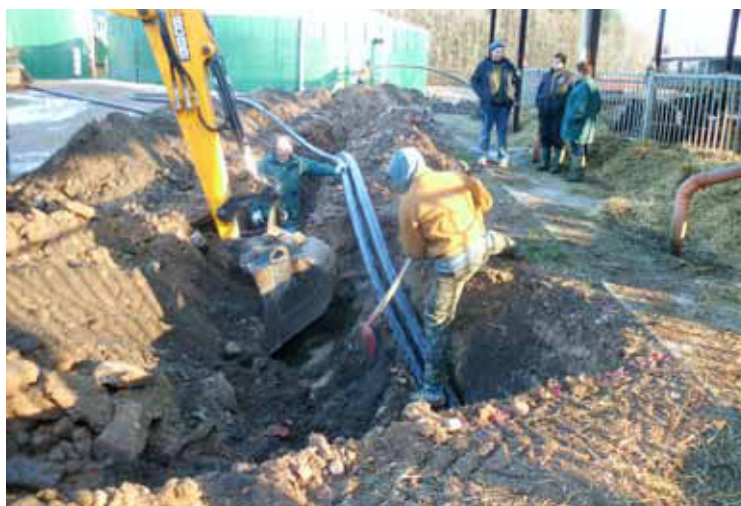
Verlegearbeiten eines Wärmenetzes einer Güllebiogasanlage (Anschluss an Wohnhaus und Melkstand mit Betriebsbüro).
