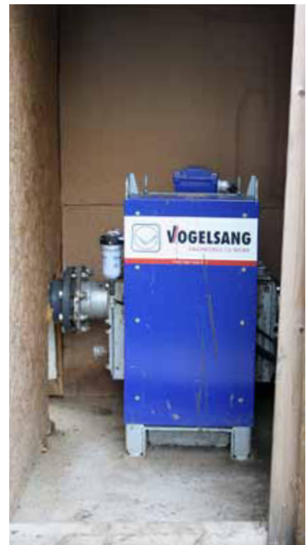
Die Drehkolbenpumpe, die die Gülle in den Fermenter fördert, befindet sich in einem Holzhäuschen.
