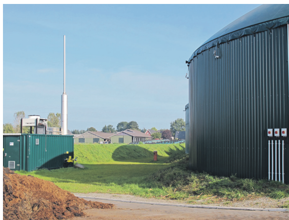
Die Gülle wird aus den 300 m entfernten Ställen in die Anlage gepumpt, die Wärme von der Biogasanlage zurück zum Hof geleitet.
